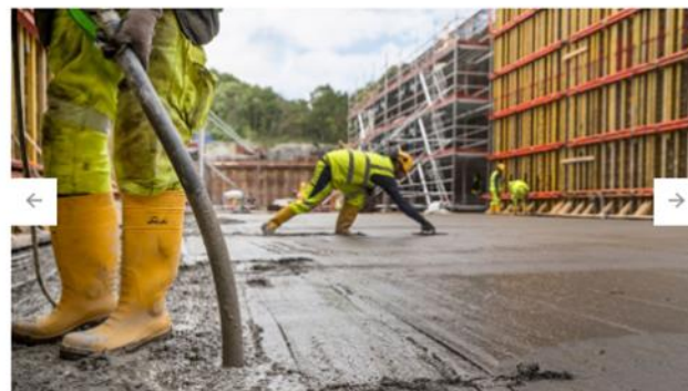
1 av 3 - Efter nästan ett år av testning och dokumentation kunde Skanska gjuta Grön anläggningsbetong på Hamnbanan i Göteborg.
